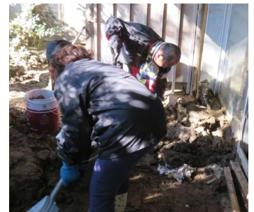
住宅・お庭の土砂を土嚢に詰めて搬出します。← ↑
